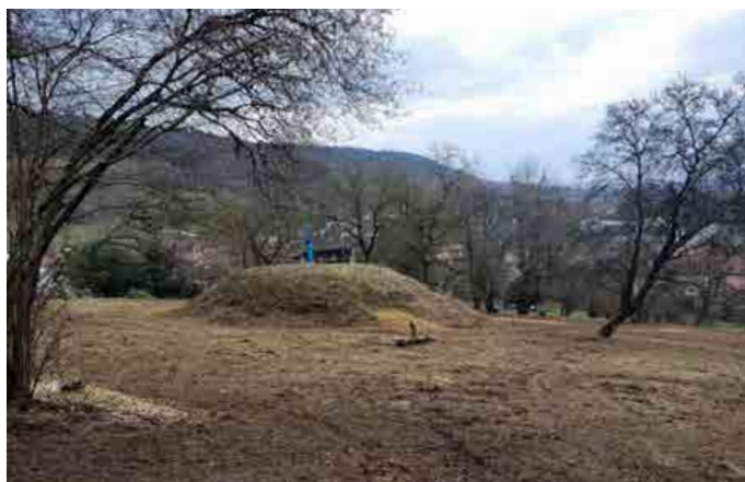
► LAGNEY - Travaux de tonte et de défrichage autour du réservoir d'eau potable - 208 €
