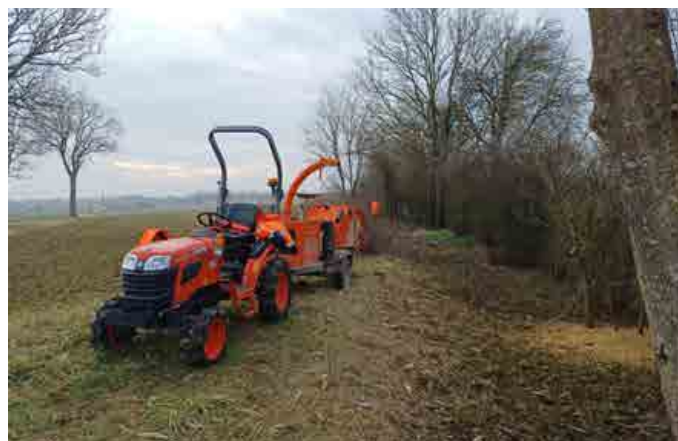
► VOIE VERTE TOUL-THIAUCOURT - Ouverture du chemin dans le cadre des travaux d'aménagement - 360 €
