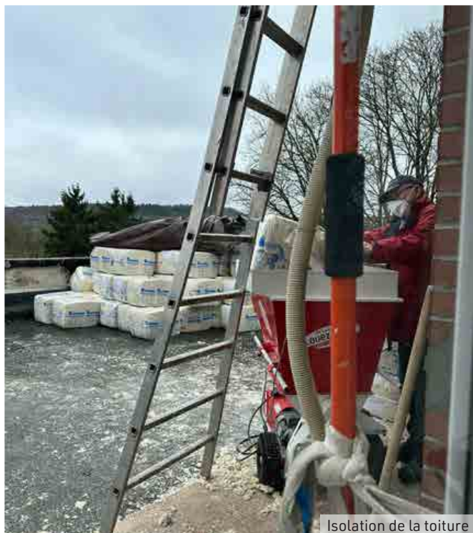
Isolation de la toiture
