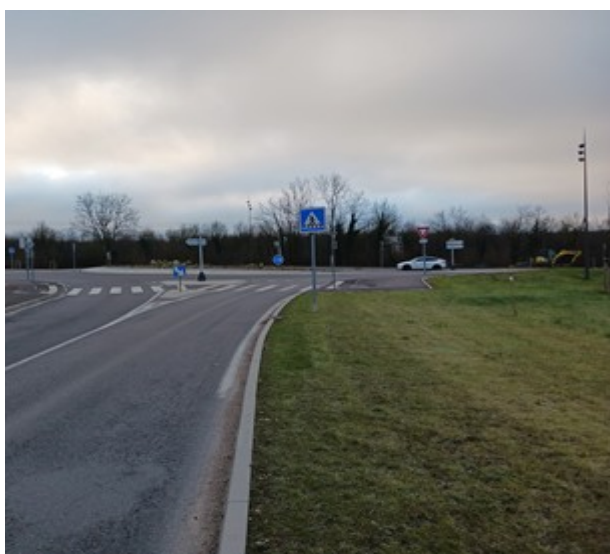
Giratoire RD400/entrée ZAE nouvellement aménagé
