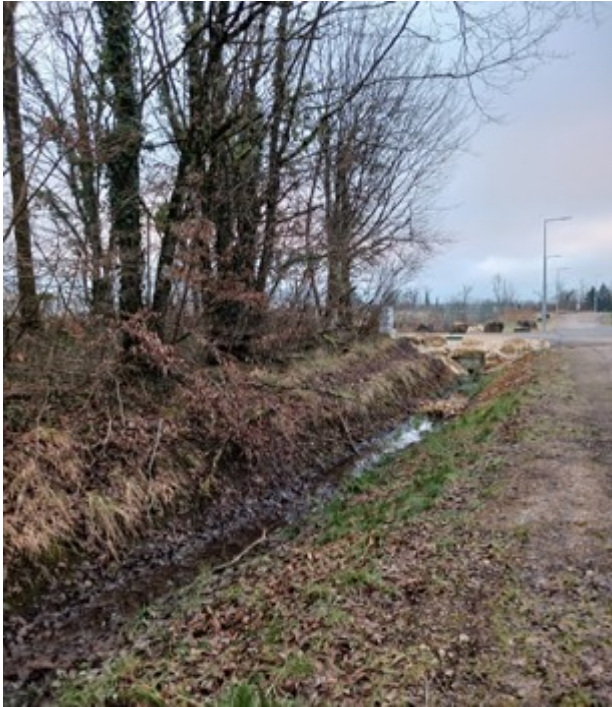
Types de fossés qui seront recalibrés pour évacuer les eaux pluviales de la ZAE vers la forêt de Haye -Photos CE
