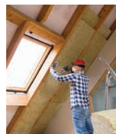
Isolation des combles avec aides de l'OPAH.
