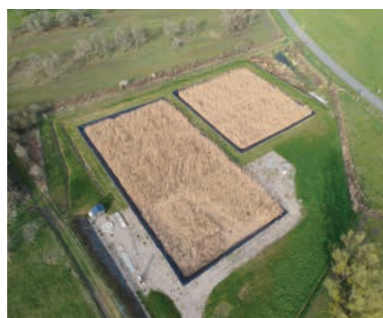
Mise en service en 2020, la station d'épuration de Charmes-la-Côte traite aussi les eaux usées de Domgermain.
