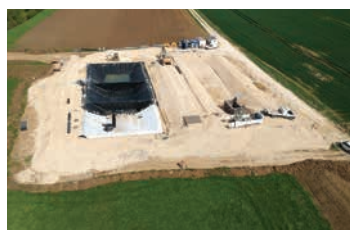
Chantier de la station d'épuration de Bouvron.
