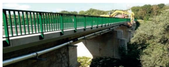
La nouvelle conduite, de diamètre 200, a été positionnée le long des 140 mètres du pont, comme elle l'était à l'origine.
